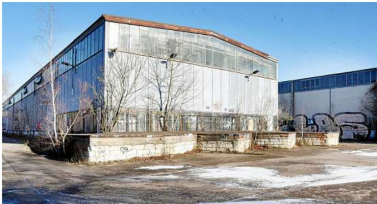
Die Hallen der Stadt auf dem EOW-Gelände sollen abgerissen, die betonierten Flächen entsiegelt werden.
